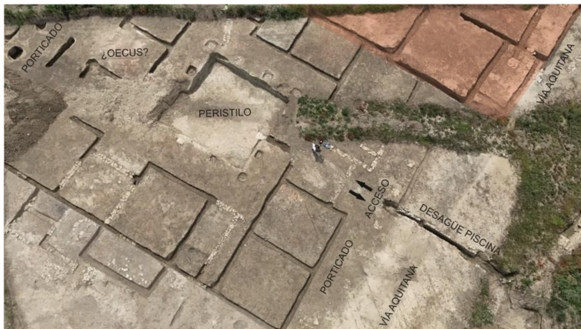
Figura 12. Ortofoto de la Vía y de las domus central y occidental situadas al sur de la misma. Se indican las estancias mejor conocidas de la pars urbana de la domus central. Imagen de Alfredo Moneo retocada
